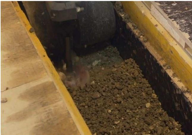
(a) Compaction d'un mur en pisé
