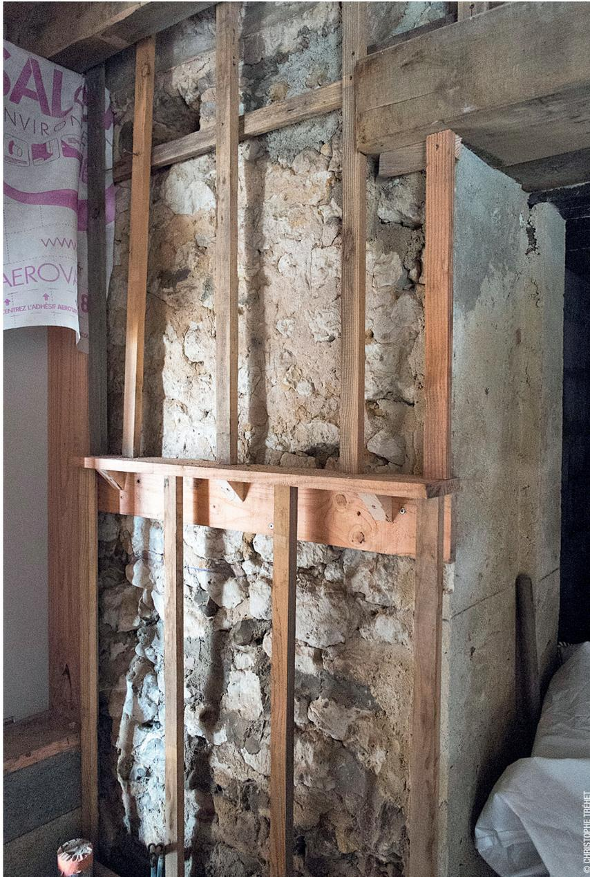
Ossature rapportée pour projection de terre-chanvre. Cette technique est particulièrement adaptée à la correction thermique des murs de pierre.
