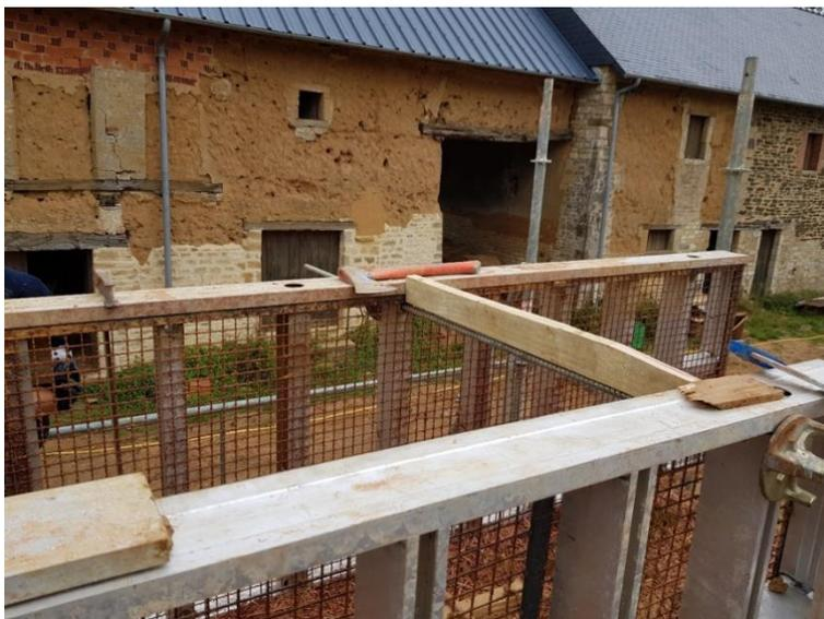
Figure 20 : Photo montrant l'espace d'un coffrage en utilisant une barre d'espace en bois. Photo : François Streiff.
