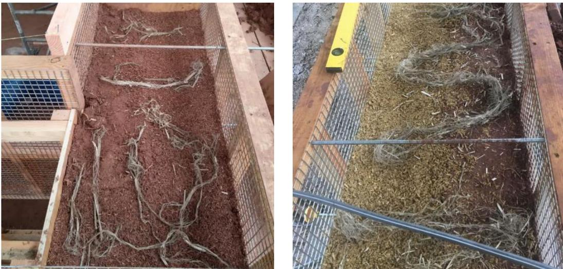
Figure 26 : Paille de chanvre posée, après chaque couche successive, perpendiculaire à la longueur du mur CobBauge. Photos : Jim Carfrae.
