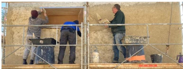
Figure 3. Exemple d'un enduit à la chaux appliqué à un mur CobBauge.
