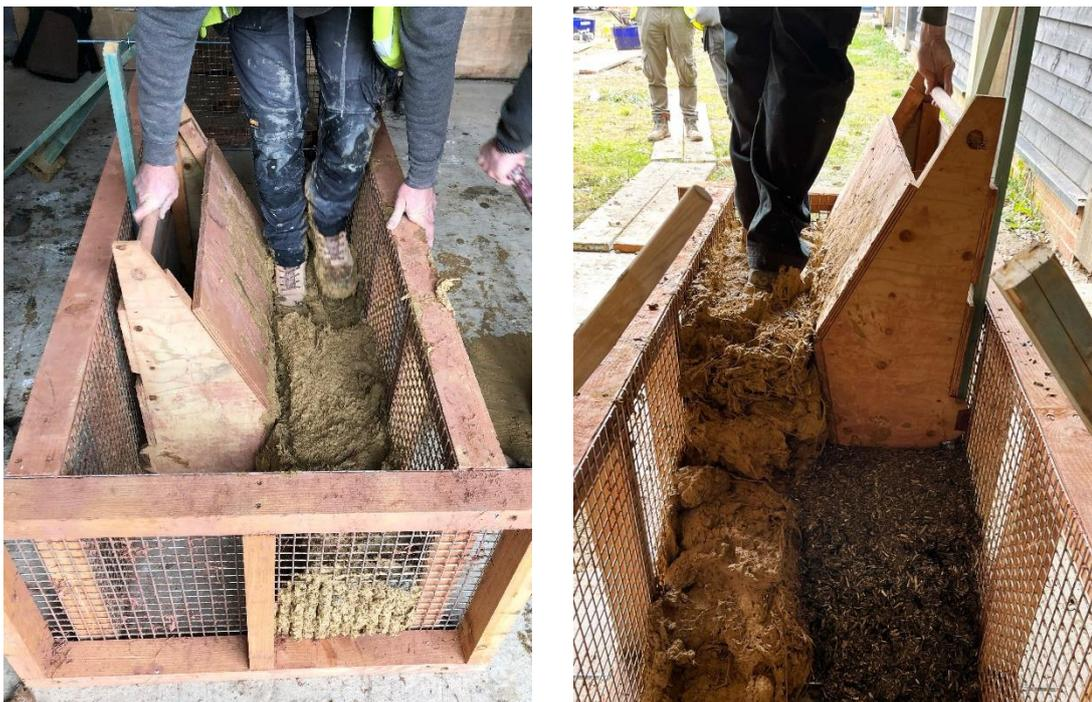
Figure 24 : Outil de pose et technique de compactage par piétinement pour la couche structurelle.
