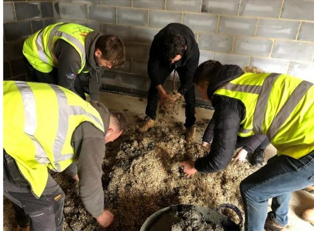
Figure 10 : Mélange de la terre allégée sur site avec une bétonnière (gauche) et à la main (droite).
