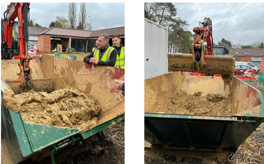
Figure 5 : Mélange de la bauge structurelle dans une benne avec le godet d'une pelleuse. Photo : Katey Oven.
