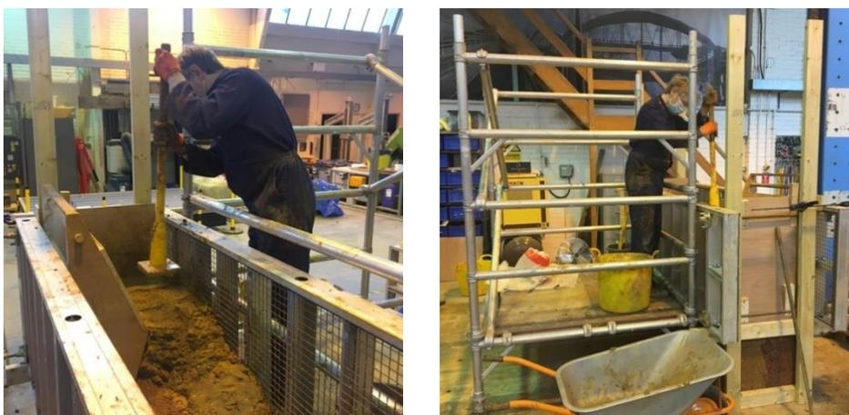
Figure 36 : Utilisation d'une petite plateforme d'échafaudage afin d'aider la construction de bas niveau. Photos : Plymouth University, projet CobBauge.
