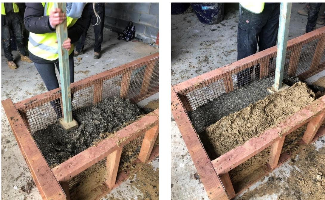
Figure 25 : Outil de damage et technique pour la couche thermique. Photos : Tom Booen.
