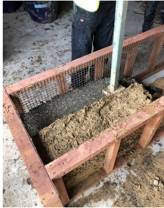
Figure 25 : Outil de damage et technique pour la couche thermique. Photos : Tom Booen.
