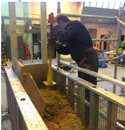
Figure 36 : Utilisation d'une petite plateforme d'échafaudage afin d'aider la construction de bas niveau. Photos : Plymouth University, projet CobBauge.
