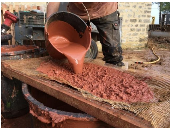
Figure 9 : Tamisage de la barbotine d'argile. Photo : François Streiff.
