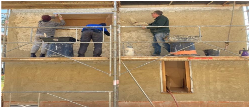
Figure 3 : Exemple d'un enduit à la chaux appliqué à un mur CobBauge. Photo : Raphaël Rattier.
