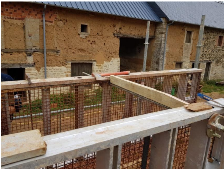
Figure 20 : Photo montrant l'espacement d'un coffrage en utilisant une barre d'espacement en bois. Photo : François Streiff.
