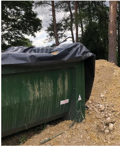
Figure 34 : Bâche recouvrant le mélange de bauge. Photo : Katey Oven.
