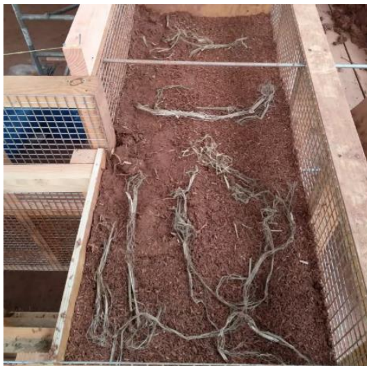
Figure 26 : Paille de chanvre posée, après chaque couche successive, perpendiculaire à la longueur du mur CobBauge. Photos : Jim Carfrae.
