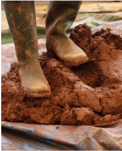
Figure 4 : Mélange de la bauge structurelle avec une machine ou avec les pieds. Photo : Plymouth University, CobBauge project (2021) (gauche), François Streiff (droite).
