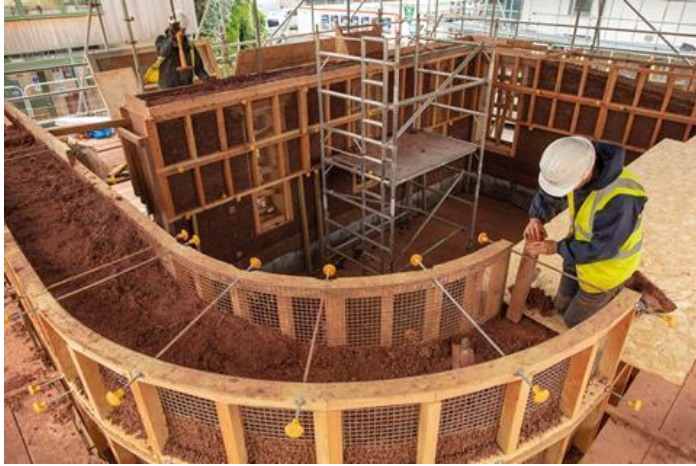
Figure 37 : Échafaudage à l'intérieur et à l'extérieur d'un mur de CobBauge pendant sa construction. Photo : Plymouth University, projet CobBauge.
