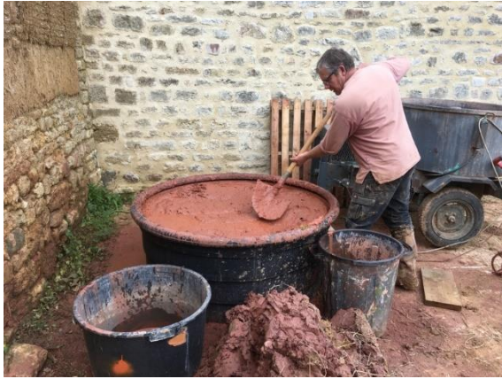
Figure 7 : Mélange de la terre avec de l'eau, dans un grand seau, pour former la barbotine d'argile. Photo : François Streiff.
