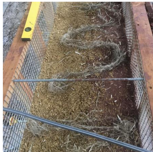
Figure 26 : Paille de chanvre posée, après chaque couche successive, perpendiculaire à la longueur du mur CobBauge. Photos : Jim Carfrae.
