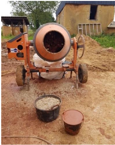
Figure 10 : Mélange de la terre allégée sur site avec une bétonnière (gauche) et à la main (droite). Photos : François Streiff (gauche) & Anthony Hudson (droite).
