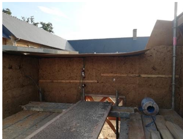
Figure 33 : Plaques de bois protégeant le haut d'un mur en CobBauge. Photo : François Streiff.
