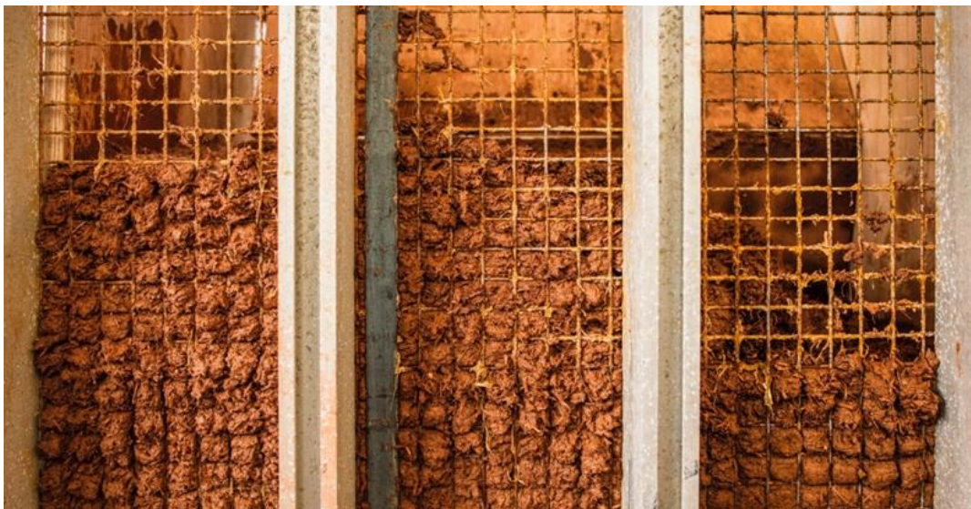
Figure 29 : Photo montrant le compactage de la terre allégée vu à travers le grillage. Photo : Plymouth University, projet CobBauge.
