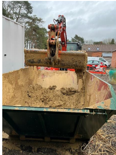
Figure 5 : Mélange de la bauge structurelle dans une benne avec le godet d'une pelleuse. Photo : Katey Oven.
