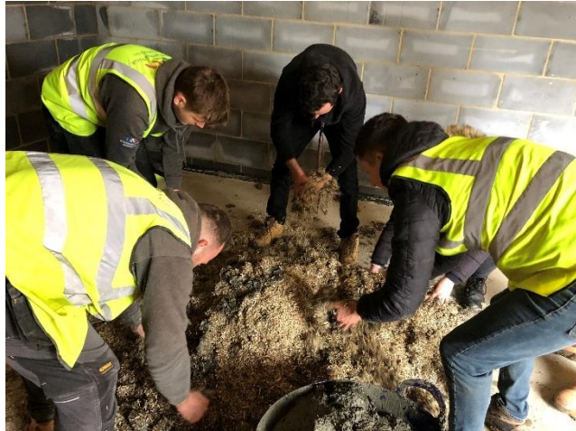
Figure 10 : Mélange de la terre allégée sur site avec une bétonnière (gauche) et à la main (droite). Photos : François Streiff (gauche) & Anthony Hudson (droite).
