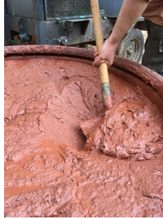
Figure 7 : Mélange de la terre avec de l'eau, dans un grand seau, pour former la barbotine d'argile. Photo : François Streiff.
