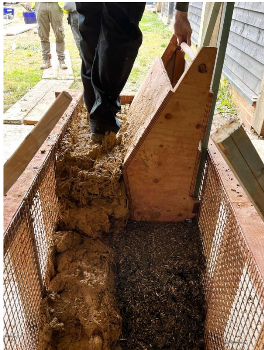
Figure 24 : Outil de pose et technique de compactage par piétinement pour la couche structurale. Photos : Tom Booen.
