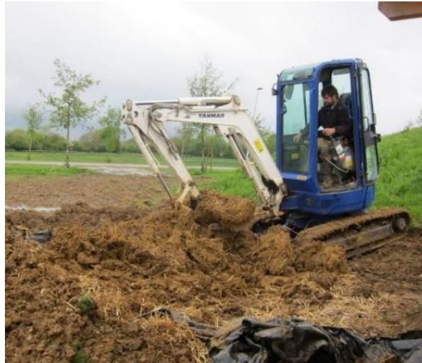
Figure 4 : Mélange de la bauge structurelle avec une machine ou avec les pieds. Photo : Plymouth University, CobBauge project (2021) (gauche), François Streiff (droite).
