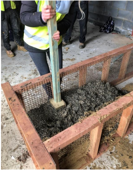
Figure 25 : Outil de damage et technique pour la couche thermique. Photos : Tom Booen.
