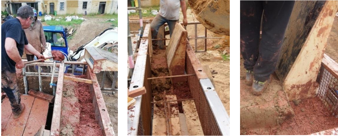
Figure 28 : Utilisation d'un outil de pose sur site. Photo : François Streiff.
