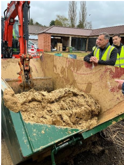
Figure 5 : Mélange de la bauge structurelle dans une benne avec le godet d'une pelleuse. Photo : Katey Oven.
