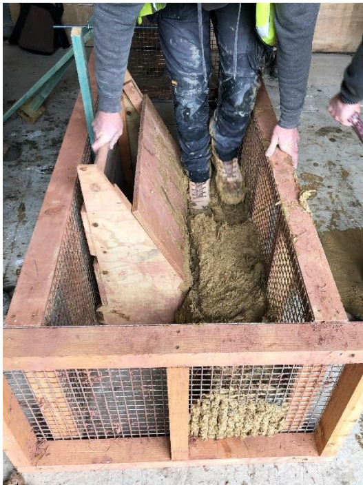
Figure 24 : Outil de pose et technique de compactage par piétinement pour la couche structurale. Photos : Tom Booen.
