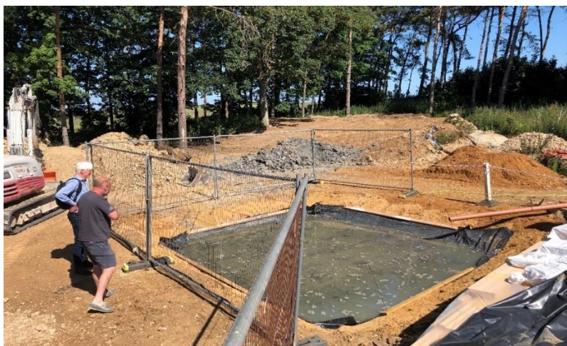
Figure 6 : Trempage du mélange de la terre thermique dans une fosse étanche. Photo : Tom Booen.
