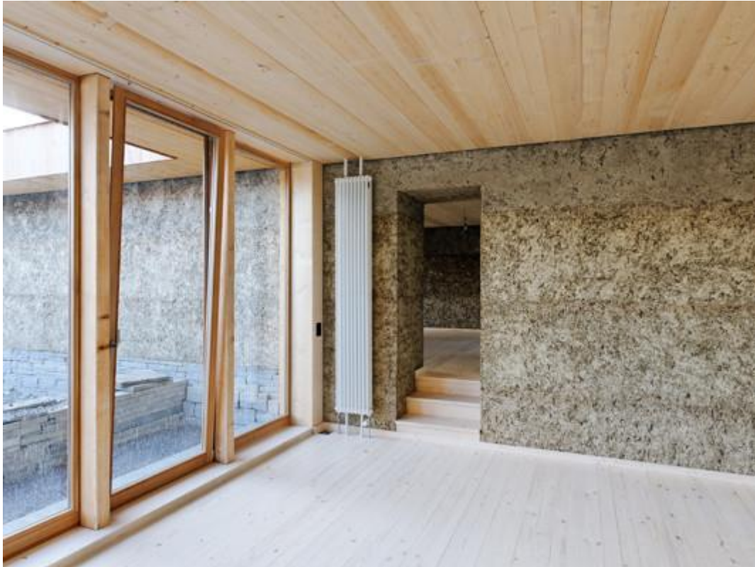
Cob in Modern Construction, spaceshop-architekten - Wohnhaus Flury - Deitingen
