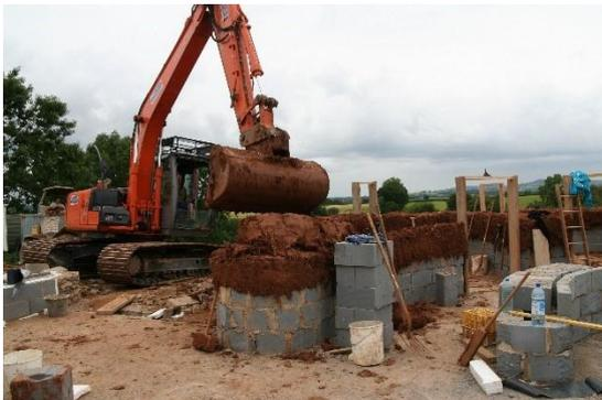
Mise en œuvre à la pelle mécanique – Dingle dale, Kevin Mc Cabe
