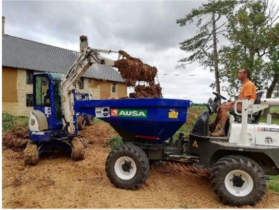
Les deux mélanges ont été ici mis en œuvre sur le même principe que le premier essai, avec une partie porteuse en moyenne de 45cm d'épaisseur et une partie isolante de 25cm. Le mur a été monté sur 1.1m de hauteur. Il a été décoffré le lendemain sans difficulté particulière.
